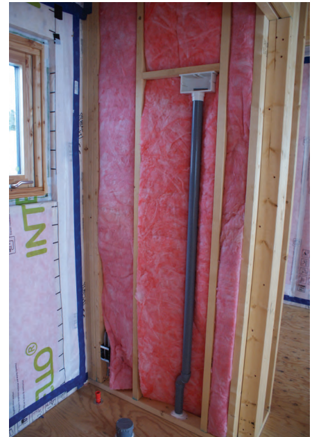
内壁は2×4の90mm、外壁は2×6の140mm
